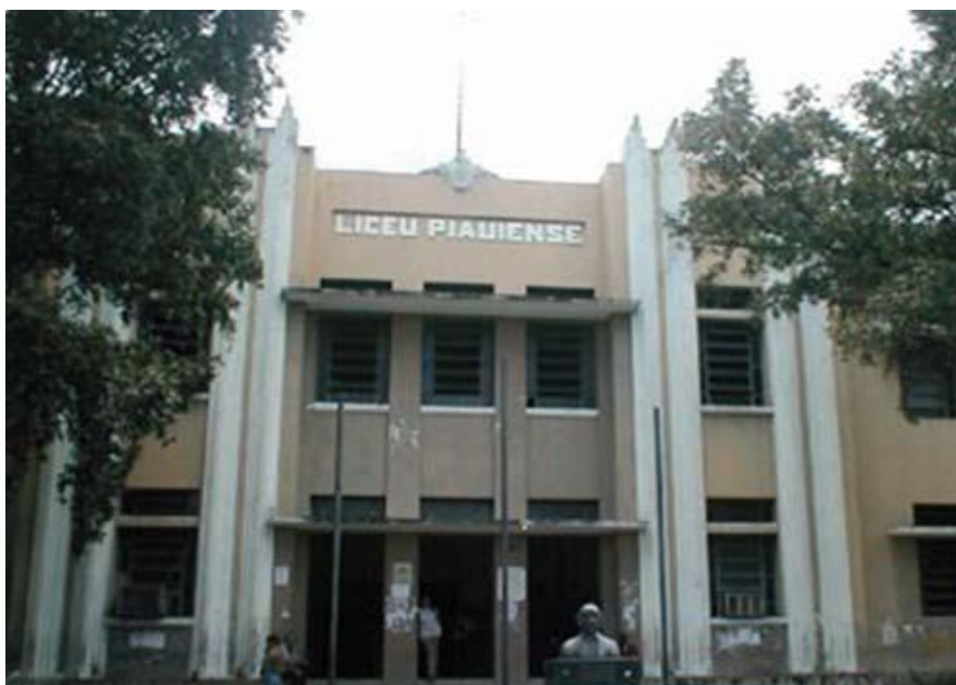
Foto 08 Fachada principal do Colégio Estadual “Zacarias de Góis”- Liceu Piauiense
