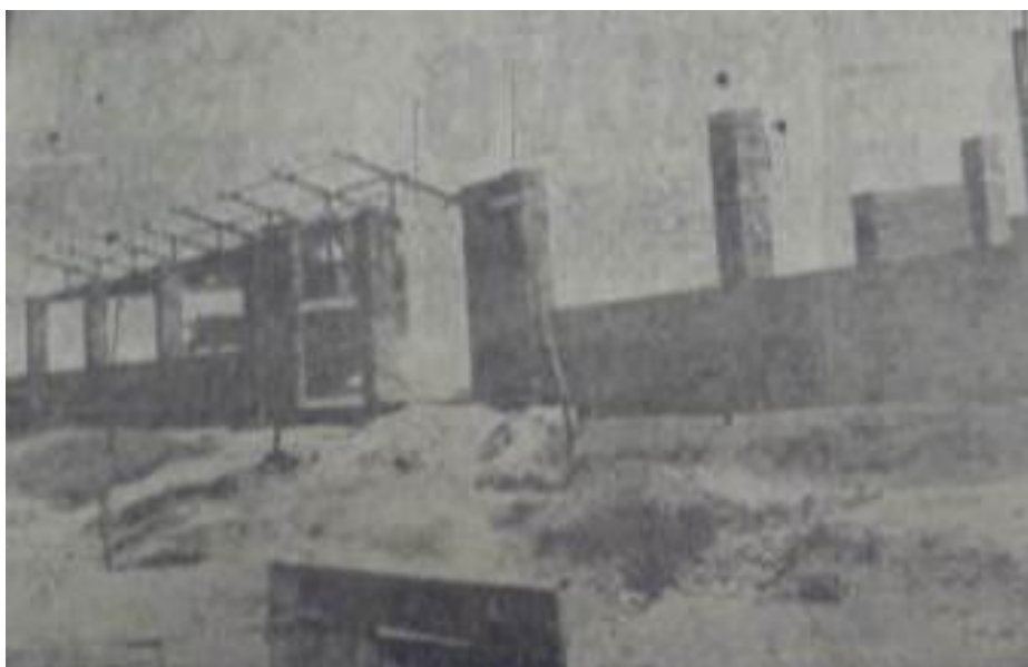
Foto 07: Ginásio em construção
